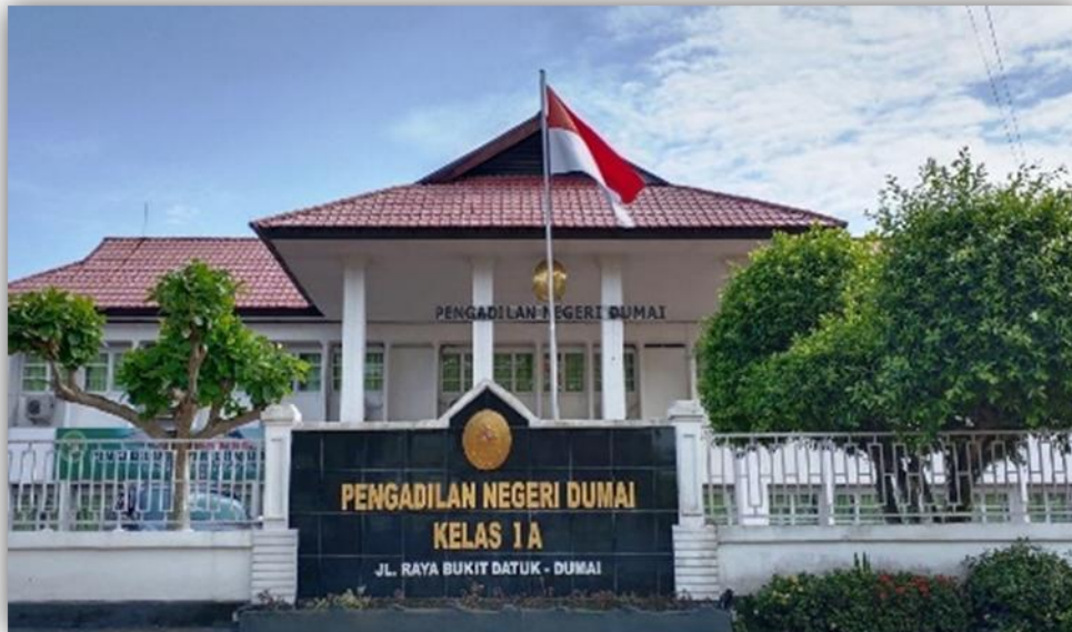
Gambar 1.3. Gedung Pengadilan Negeri Dumai Kelas IA
